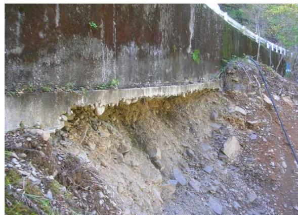
通行止めができない区間であることから、施工中に片側交互通行が可能である工法であることも考慮して比較検討を行った結果、宮崎須木線では補強土壁工法（ジオテキスタイル）国道 265 号では軽量盛土工法（EPS）での復旧計画となった。
